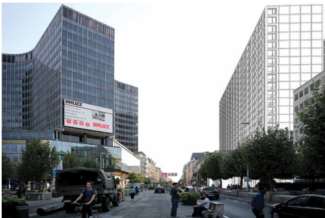
Réaffectation de la tour Philips, place de Brouckère, Bruxelles, Conix RDBM
