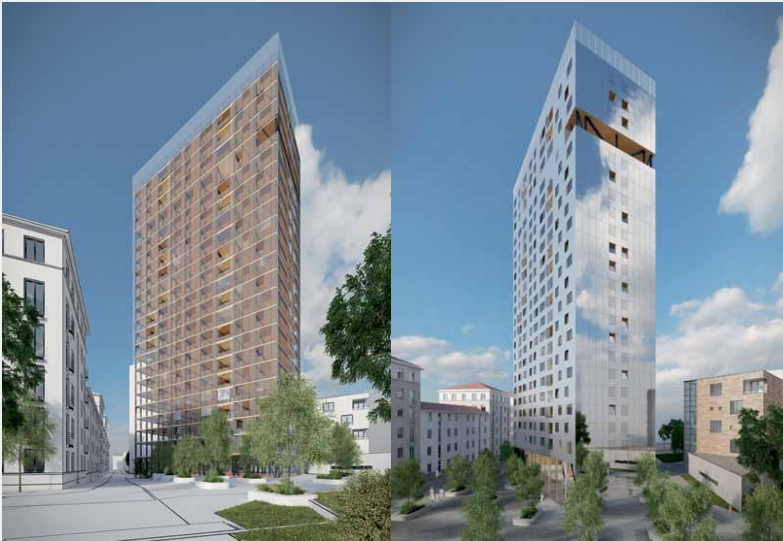
Renovatie van de Brunfautoren, Sint-Jans-Molenbeek, Atelier 229 en Dethier Architecture
