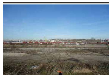
Naam project: Schaarbeek-Vorming Gemeente: 1000 – 1140 Projectdrager: citydev.brussels Beschrijving: Inrichting van een zone voor logistieke en productieve activiteiten – openleggen van de Zenne
