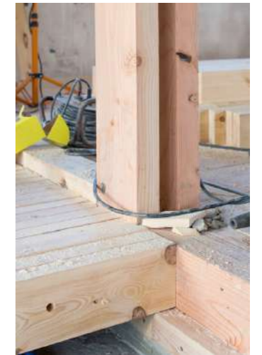
AgwA - Verbiest - structure bois, mise en oeuvre des blocs de chanvre
