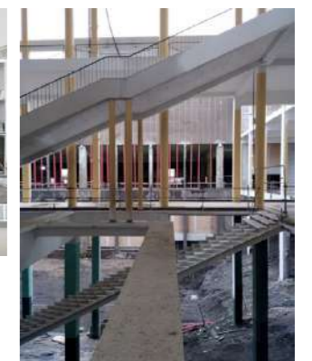
AgwA - Palais des Expositions Charleroi Interventions structurelles dans l'existant
