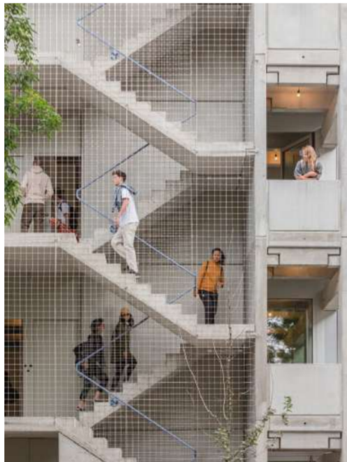
voorbeeld van demontabel bouwen met betonnen elementen referentie : FAR frohn&rojas - Wohnregal Apartments and Ateliers
