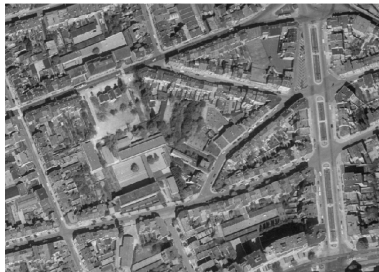
Luchtfoto 1971, met de te behouden schoolgebouwen en het Landhuis
