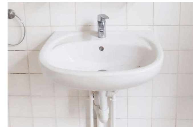
Sanitaire toestellen worden in de mate van het mogelijke hergebruikt
