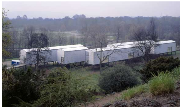
Pavillon Préfabriqué - Jean Prouvé
