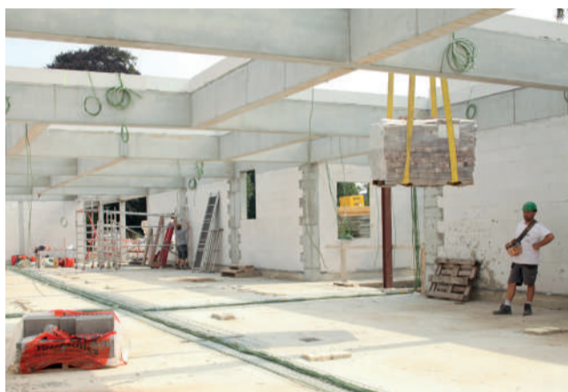
Musée du Folklore de Mouscron - V+ Système poteaux poutre ici avec isolation en béton cellulaire
