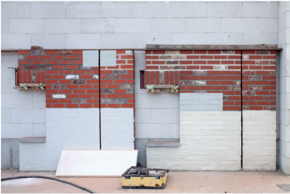
Musée du Folklore de Mouscron - V+ Parement de briques mêlant brique de récupération et neuve. Le tout est chaulé
