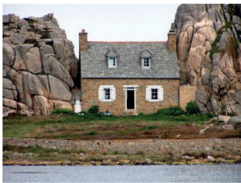
Bâtiment vernaculaire entre deux rochers Castel Meur à Plougrescan
