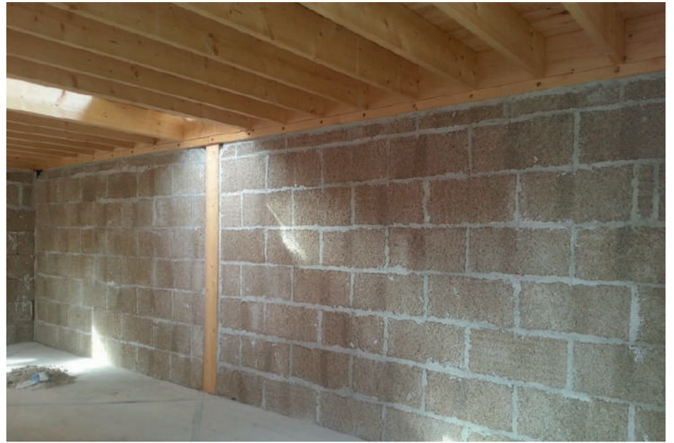
Bloc Chaux Chanvre Inséré dans un système poteaux poutres pour l'isolation thermique et l' remplissage
