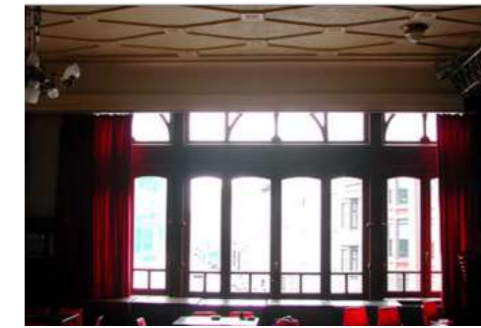
Ontdubbelt schrijnwerk in de balzaal in de Vooruit
