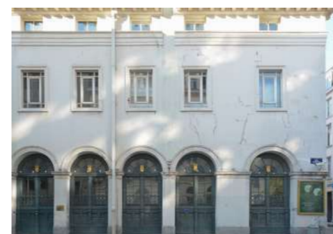
Foto van de bestaande toestand
