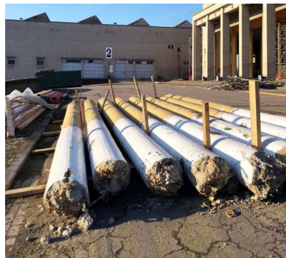
doorzon interieur architecten, CHAPEX, Palais des Expos, Charleroi (BE) Kolommen, klaar voor hergebruik.
