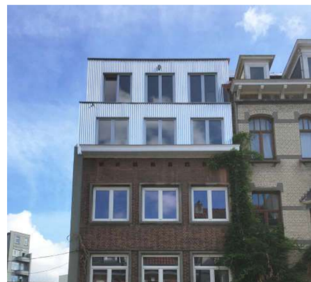
Un matériau déjà testé | Bardage alu et connections réversibles (ref. Kaderstudio, Timmermans)
