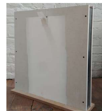
Cloison avec panneau de finition intérieur avec fixation invisible
