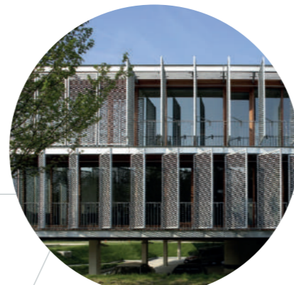
Tweede gevelschil in strekmetaal Administratief centrum Bonheiden LAVA Architecten
