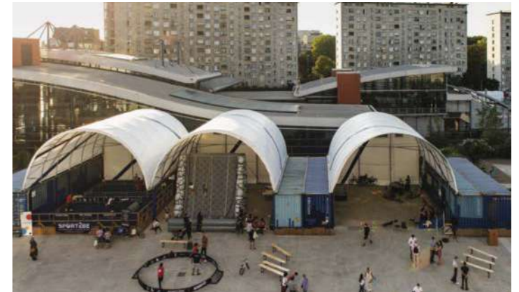
Structures démontables pour accueillir des activités Molenwest - Molenbeek
