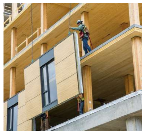
PREFABRICATIE VAN HOUTEN GEVELPANELEN PRÉFABRICATION DE PANNEAUX DE FAÇADE EN BOIS
