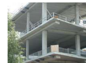
11. PREFAB BÉTONSTRUCTUUR 11. STRUCTURE PRÉFABRIQUÉE EN BÉTON
