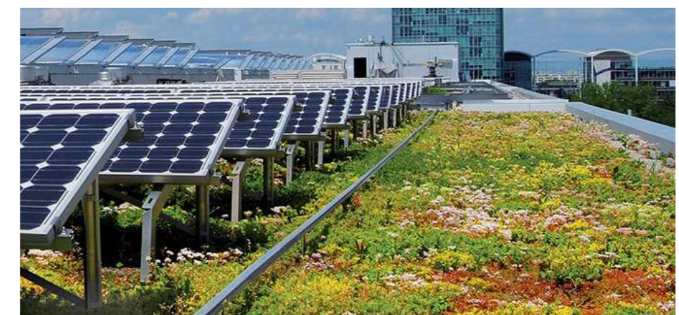
Cohabitation positive des panneaux photovoltaïques et de toitures vertes écologiques
