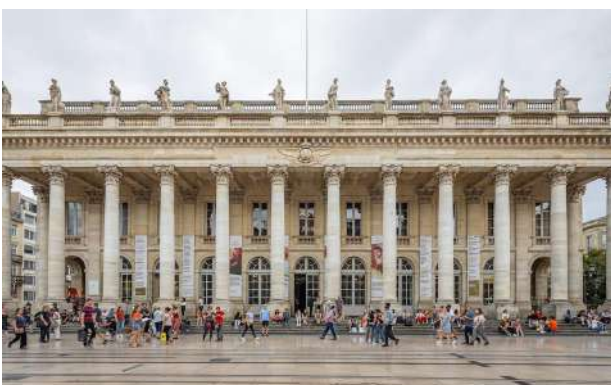
img. 37: Exemples de réalisation - Opera de Bordeaux (France)
