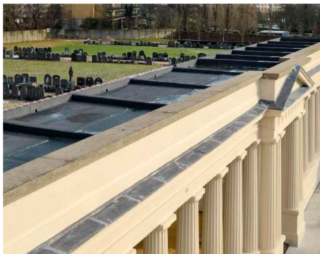
img. 18: Galeries funéraires de Molenbeek (G. De Kinder 2016) - Protections des ouvrages saillants avec un revêtement en plomb
