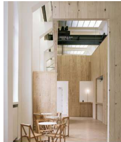
Iseip - CLT cloué - Bureau Nord
