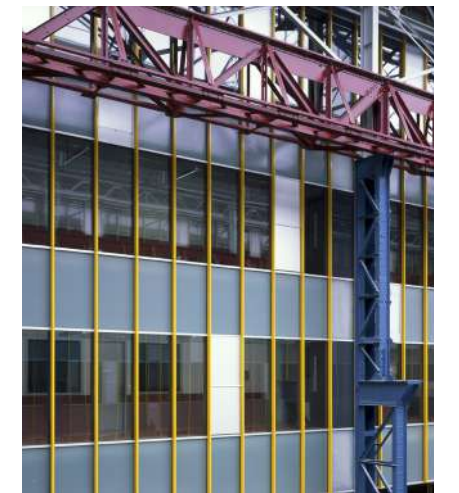
Colorimétrie des éléments industriel - Lycée Hotelier - Caruso St John
