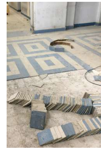
Récupération du carrelage
