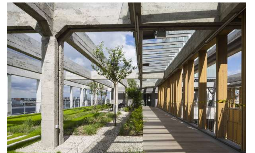
Toiture activée - BETC Paris - Jung architecture
