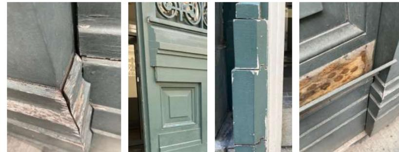
Détails des assemblages des menuiseries des portes du r-d-c
