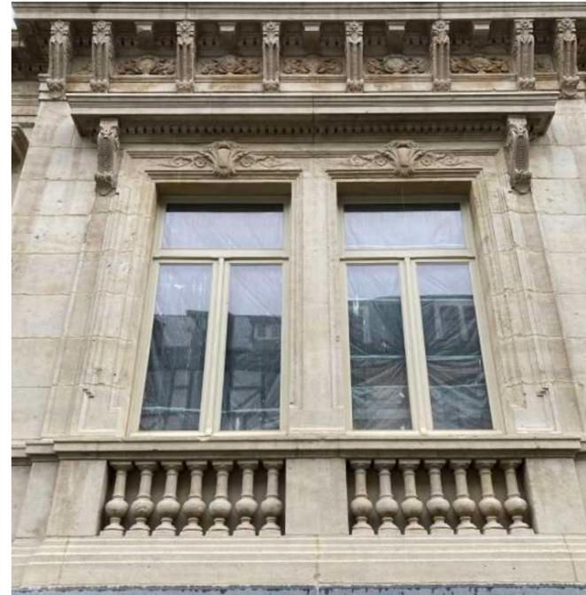
Exemple de châssis reconstruits, similaires aux châssis historiques conservés (1868), avec étanchéité à l'air et double vitrage.
