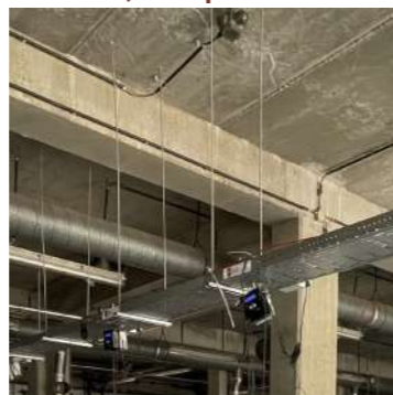
Structure béton conservée au maximum Si hourdis démontés (sciés) > réutilisation dans le bâtiment même
