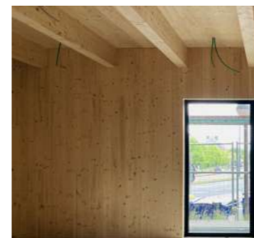
Nouvelles structures en bois: Poutres/colonnes en LMC Plancher en CLT
