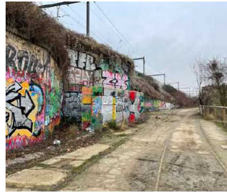
KEERMUUR LANGS DE SPOORWEG
