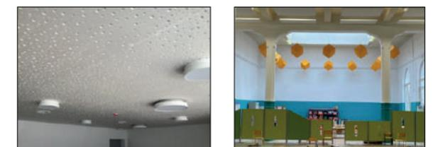
Figure 4 : Plafond absorbant perforés (à gauche) et éléments volumétriques absorbants suspendus (à droite).
