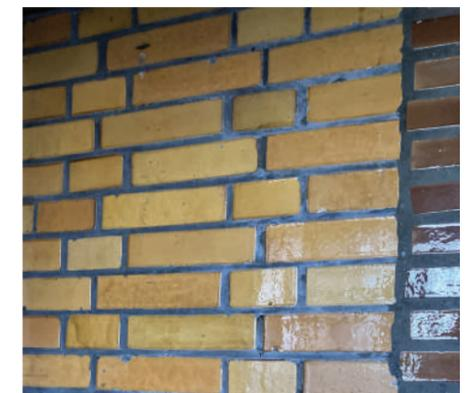
Travail de calepinage et colorimétrie des briques vernissées Kessels sur les façades et intérieurs du couloir et sanitaires. Facades et intérieurs sauvegardés.
