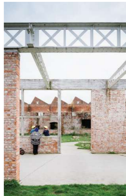
LES TRACES DES DÉPÔTS EXISTANTS
