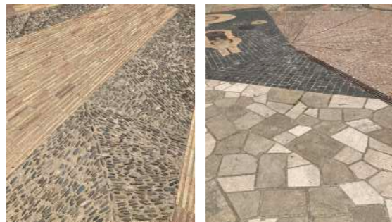
SOL FAIT À PARTIR DES MATÉRIAUX DE RÉCUPÉRATION
