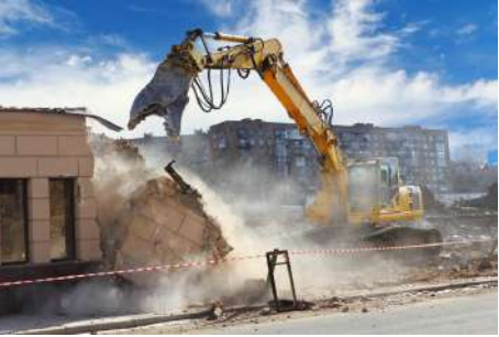
les chantiers de démolition peuvent être source de nombreuses nuisances s'ils ne font pas en amont l'objet d'un plan de gestion adéquat
