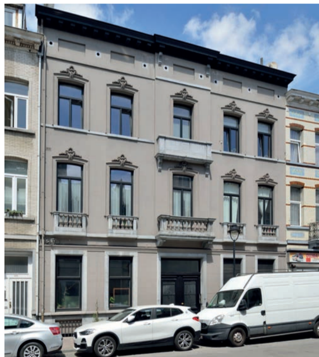
127 rue de Mérode - typologie d'immeuble de rapport
