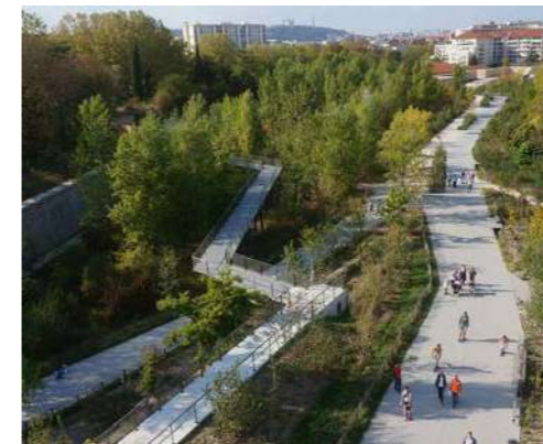
Passerelle, Parc Blandan, Lyon
