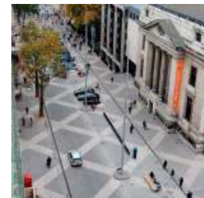
Motif de sol de façade à façade
