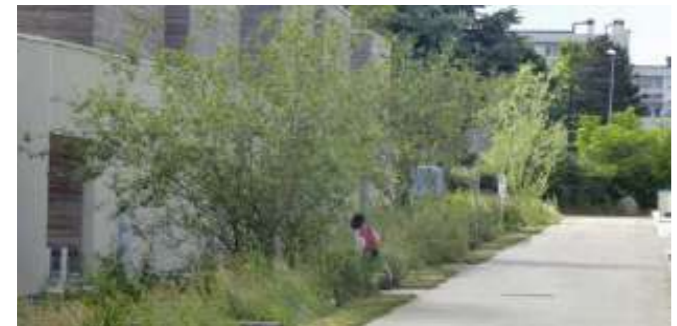
Noues végétalisées à Lyon, Briel Delmar Paysage
