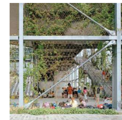
Maille végétalisée qui laisse passer les vues, Mélopée Gand, XDGA Architectes
