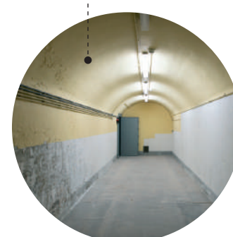
Kluis- en kelderruimtes
