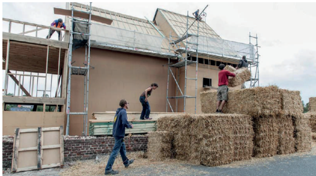
Ossature bois - Maison Bois et paille - ASBL habitat et humanisme
