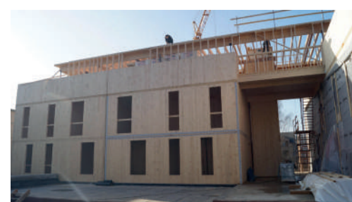
Verreries : Immeuble de 14 logements à Jambes
