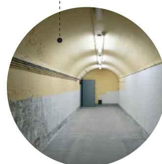
Kluis- en kelderruimtes
