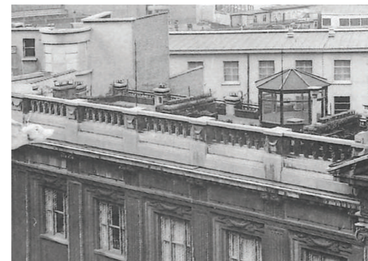
herstellen dakterras op De Rycken-vleugel
