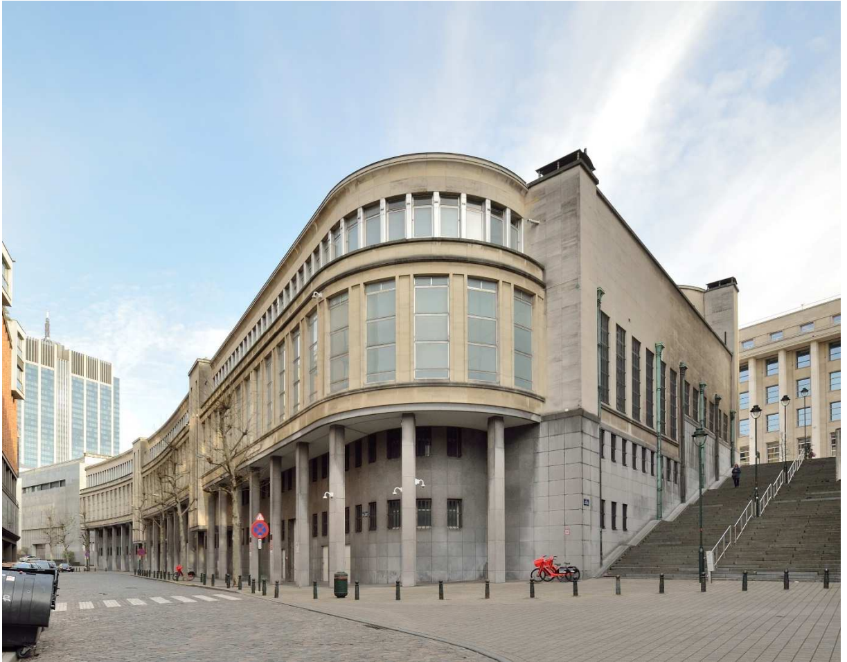
Vue de la façade côté rue Saint-Laurent et de la rue des Comédiens en escalier. La partie construite sur les colonnes, éclairée par de hautes fenêtres, correspond aux niveaux des ateliers d'imprimerie. En léger retrait le 1er étage
