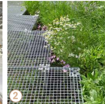
2 CAILLEBOTI MÉTALLIQUE PERMÉABLE
