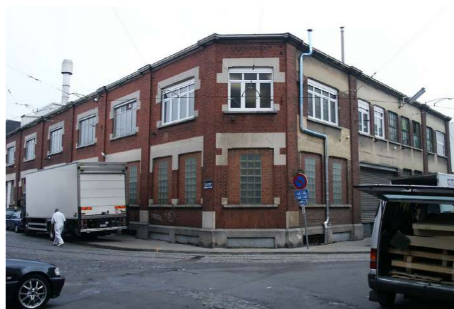
Extension moderniste située rue de l'imprimerie et rue de Belgrade
