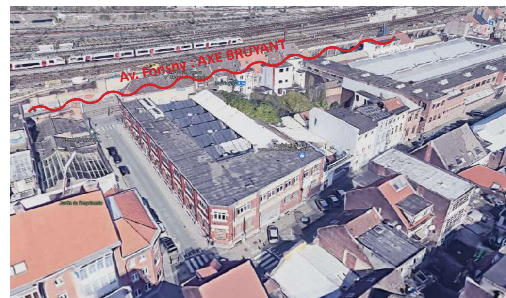
Vue aérienne : Environnement bruyant
