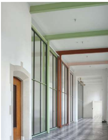
Referentie gebruik van stalen balken in contrasterende kleur ter versteviging van de structuur (Architecten DeVylder Vinck Taillieu)
