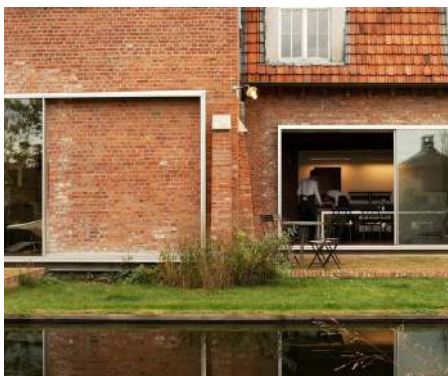
Schuifraam, openschuivend op de gevel als duidelijk nieuw element (Maarten Van Severen)
