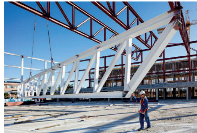
Alberto Campo Beaeza - UFV sports centre, structure en acier démontable
