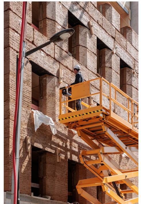
QUATRE CHEMINEES – Boulogne-Billancourt Déchelette Architecture, 2022 Fabricant : https://terrio.fr/les-blocs-terrio/
