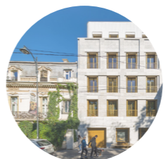
→ profondeur des fenêtres, adnba, Bucharest
