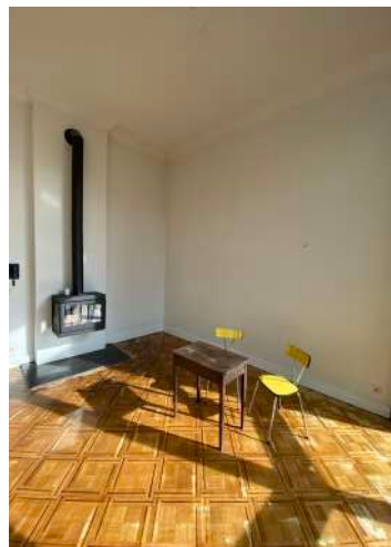
De bestaande Versaillesvloer op de gelijkvloers wordt gereïnterpreteerd in de nieuwe vloer in de voormalige gang.
