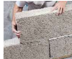
isoler la façade par l'intérieur: blocs de béton de chanvre
