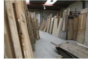
récupération des menuiseries intérieures
