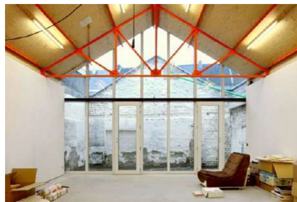
préserver les structures existantes
