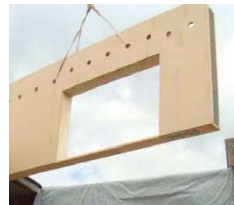
nouvelles cloisons préfabriquées
