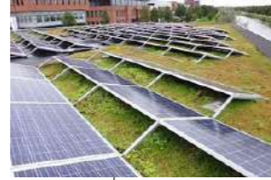
toiture verte extensive
