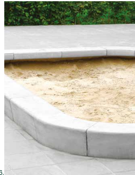
6. Zandbak prefab betonelementen
