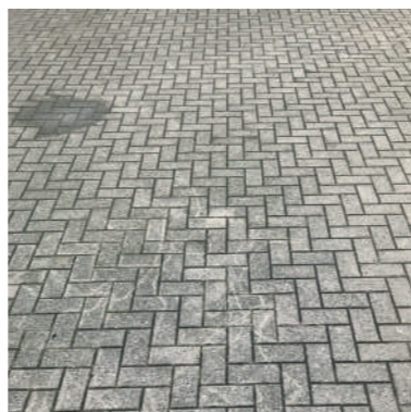
Klinkers worden hergebruikt in de buitenaanleg
