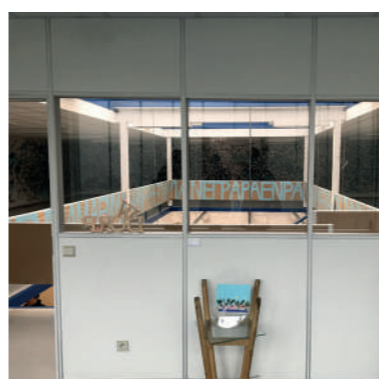
Kantoorwanden kunnen gebruikt worden in het Stookgebouw. Anders wordt Isolatie in de wanden ge-oogst in het project.
