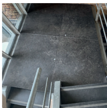
Natuurstenen worden hergebruikt in de buitenaanleg als breuksteen
