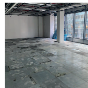
Verhoogde vloeren 25Ton Eventueel gebruikt in fabrieksgebouw
