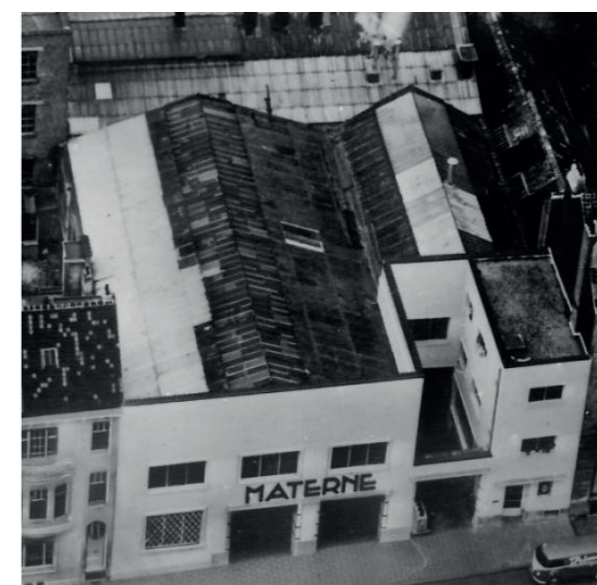
De achtergevel aan de Schildknechtstraat in de tijden van de confituurfabriek, ca. 1960.
