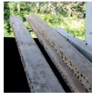
Houten balken 8 Ton Gebruikt voor box-in-box IBO
