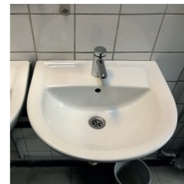
Sanitaire toestellen kunnen 1:1 hergebruikt worden.
