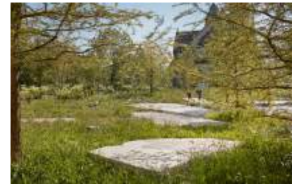
Dalle de béton réutilisée
