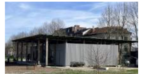
Tôles de toitures et façades démontées réemployées
