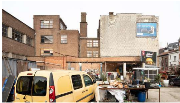
Bestaande toestand van gebouw A en B en het binnenplein
