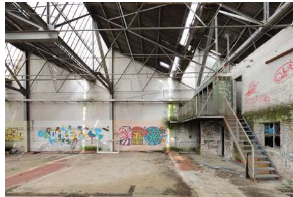
Elementen met historische waarde in de oude metaalwerkrij. We hergebruiken de stalen shedstructuur op het dak van de ateliers.
