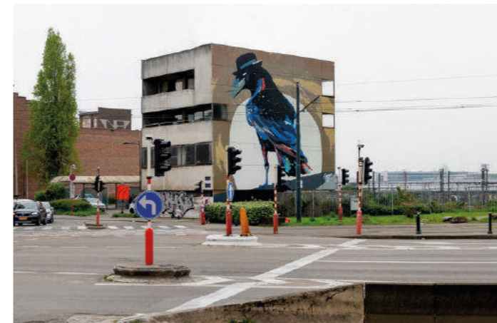
Réemploi du revêtement de façade en dalles béton du Bâtiment 178
