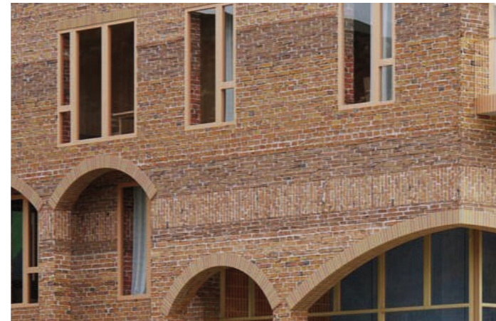
Référence bâtiment réalisé avec des briques de réemploi issu de lots différents
