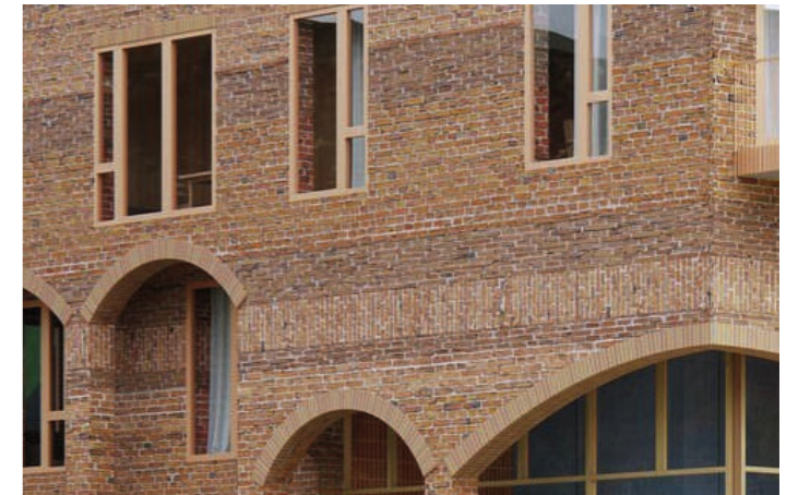
Exemple d'appareillage de briques en lits
