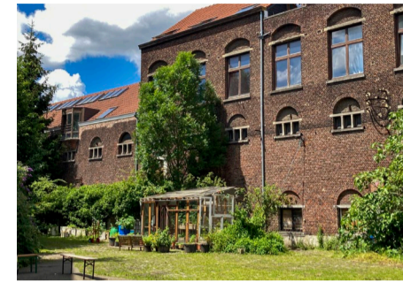
De bestaande tuingevel
