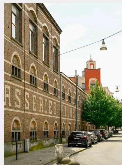
Gevel met 'Brasseries Atlas'
