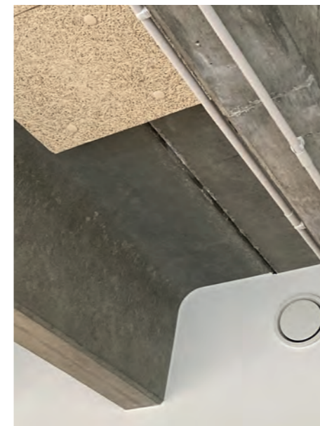
Béton apparent - techniques accessibles
