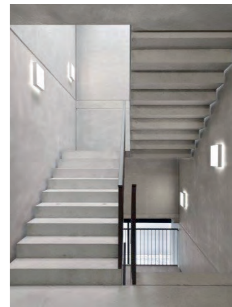
Béton intérieur apparent
