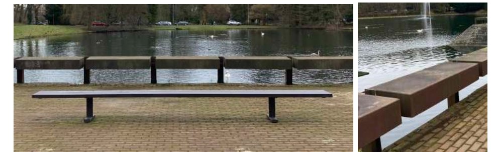
Garde de corps/assise en Corten de la terrasse de la Royale Belge
