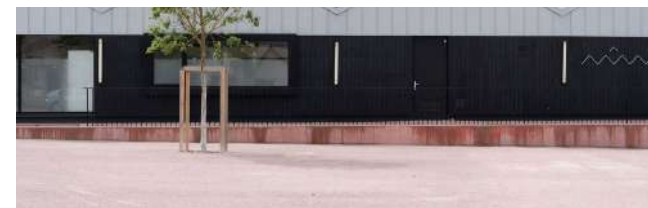
Détail muret et marches en béton rose. Grué, Place de la Précurerie, Périers
