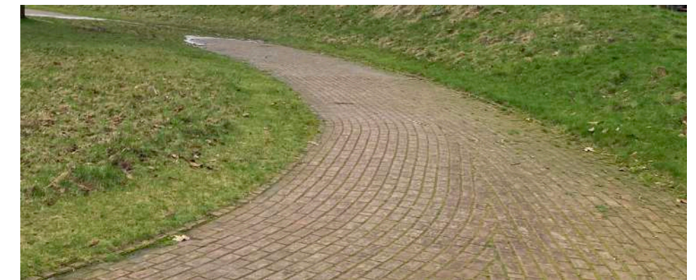
Revêtement en brique sur site
