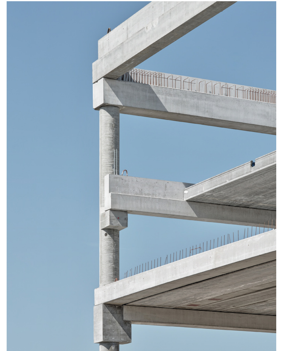
Structure porteuse en béton préfabriqué, Manufakture, Baukunst, Bruxelles
