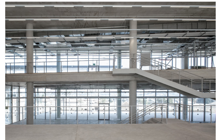
Mezzanine surplombant les espaces communs en double hauteur
