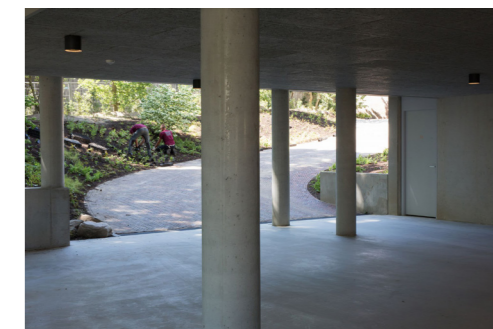
De ondergrondse ruimte werkt als een toegang voor voetgangers, fietsers en auto's. Het is een doorlopende lichtrijke ruimte door het doorzicht naar de binnentuin. Klinkebeek, Dyvik Kahlen
